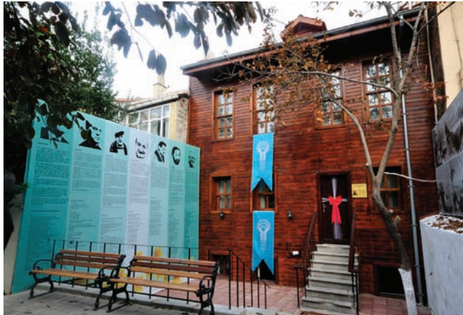
Sezai Karakoç Genel Merkez Hizmet Binası
